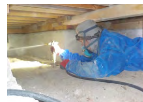
床下薬剤散布
