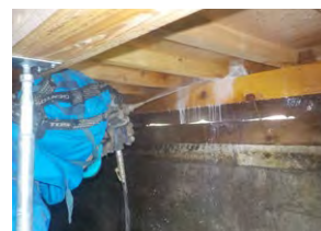
床下薬剤散布
