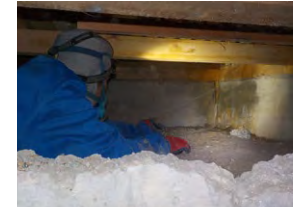
床下薬剤散布
