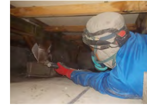
床下薬剤散布
