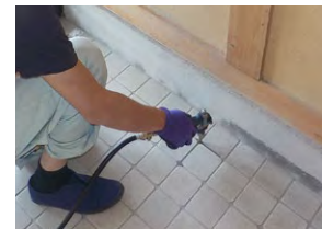
玄関薬剤注入
