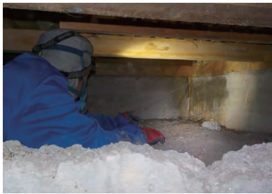
床下薬剤散布
