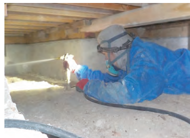
床下薬剤散布
