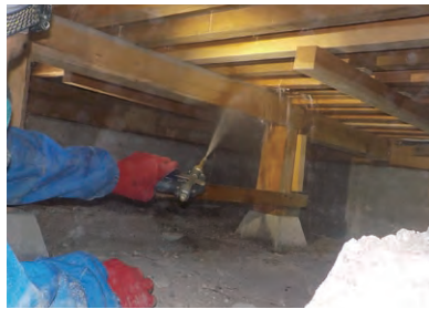
床下薬剤散布
