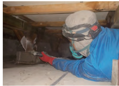
床下薬剤散布
