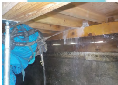
床下薬剤散布
